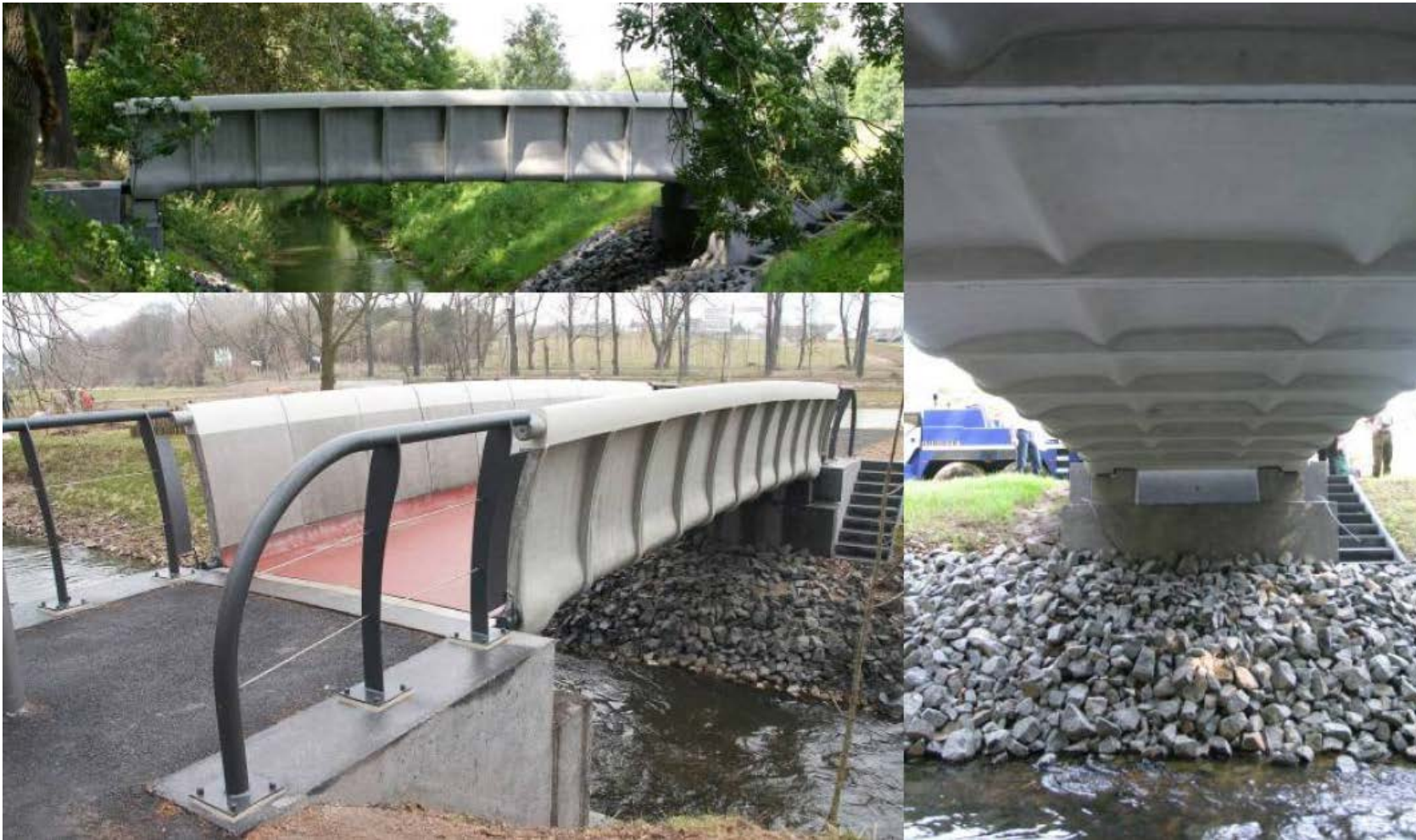
Fussgängerbrücke Oschatz: Vorgefertigte Segmente, Wandstärke ~30 mm, Längsvorspannung Quelle: Deutsches Zentrum für Textilbeton, Dresden
